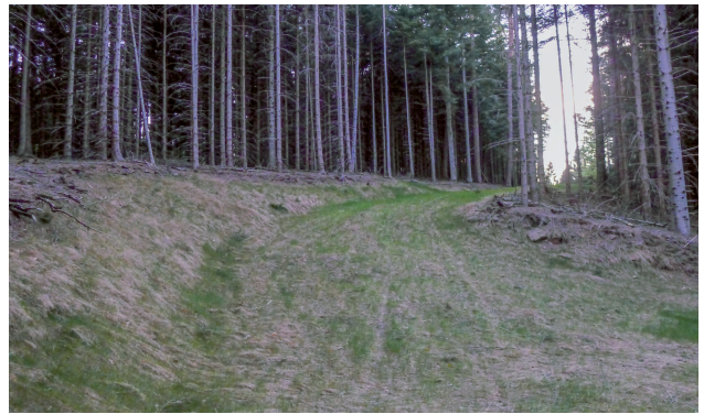
Abb. 13: Ein neu gebauter Weg. Insgesamt erfolgten am südost-exponierten Hang des „Kapf“ über mehrere Jahre ca. 1000 m Waldwege-Neubau während des Kartierzeitraums. Probeflächen-Mitte im Mai 2016.
