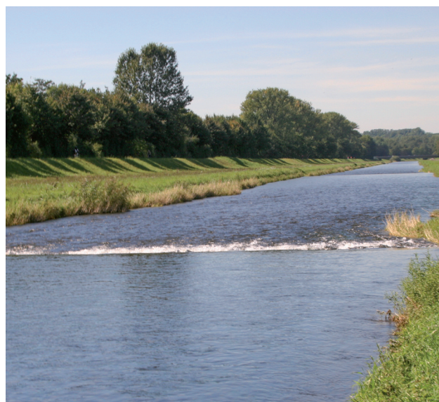
Abb. 3 und 4: Die Elz unterhalb von Köndringen EM bei Niedrigwasser und den häufig vorkommenden mittleren Abflüssen – kanalartig für große Hochwasser ausgebaut. Fotos: E. und K. WESTERMANN.
